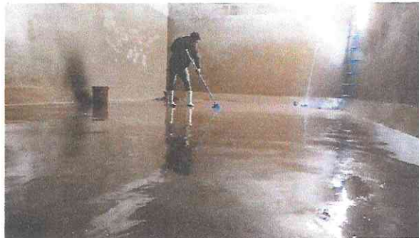
Actividad No. 11: Desinfección de tanque de Distribución sistema de agua potable, Caserío Las Minas San José Chacayá.
