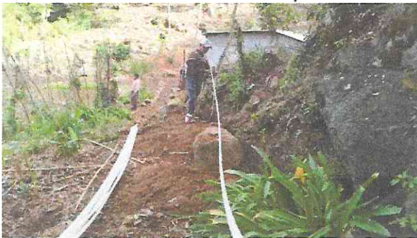
Actividad No. 15: Nuevas conexiones domiciliarias al sistema de agua potable del Caserío Las Minas del Municipio de San José Chacayá, Sololá.
