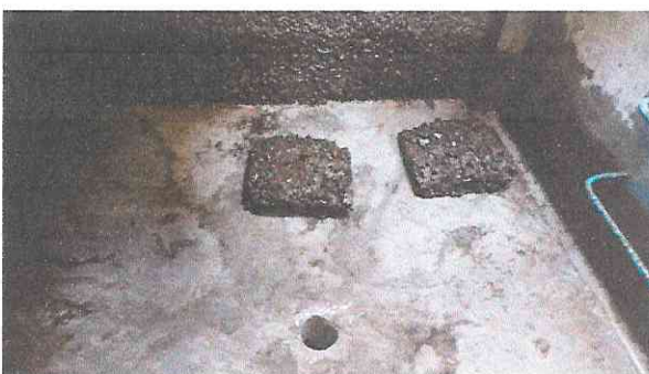
Actividad No. 8: Limpieza y mantenimiento, de caja de filtración, nacimiento del caserío Las Minas San José Chacayá.
