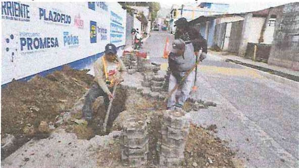
Actividad No. 13: Nuevas conexiones domiciliarias a la red de distribución del Sistema de Agua Potable, Cabecera Municipal del Municipio de San José Chacayá, Sololá.
