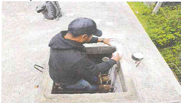
Actividad No. 7: Cloración de los Sistemas de Agua Potable del Municipio de San José Chacayá, Sololá.
