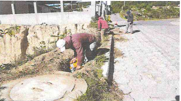
Actividad No. 14: Nuevas conexiones domiciliarias a la red de alcantarillado de la Cabecera Municipal del Municipio de San José Chacayá, Sololá.
