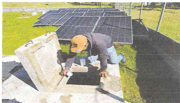
Actividad No. 7: Cloración de los Sistemas de Agua Potable del Municipio de San José Chacayá, Sololá.
