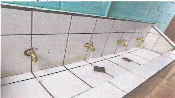
Actividad No. 17: Cambio de chorros en el módulo higiénico de la Escuela Primaria del Caserío Las Minas del Municipio de San José Chacayá, Sololá.
