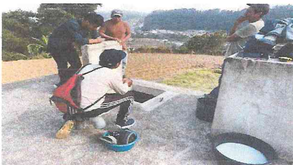
Actividad No. 18: Lavado y desinfección del tanque de distribución del Sistema de Agua Potable, Colonia Romec del Municipio de San José Chacayá, Sololá.
