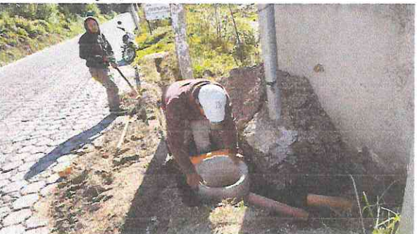
Actividad No. 14: Nuevas conexiones domiciliarias a la red de alcantarillado de la Cabecera Municipal del Municipio de San José Chacayá, Sololá.
