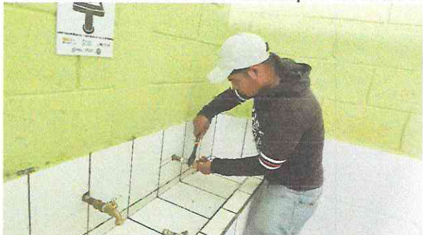
Actividad No. 17: Cambio de chorros en el módulo higiénico de la Escuela Primaria del Caserío Las Minas del Municipio de San José Chacayá, Sololá.
