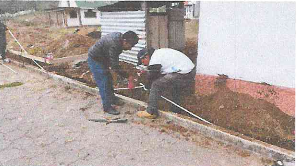
Actividad No. 13: Nuevas conexiones domiciliarias a la red de distribución del Sistema de Agua Potable, Cabecera Municipal del Municipio de San José Chacayá, Sololá.
