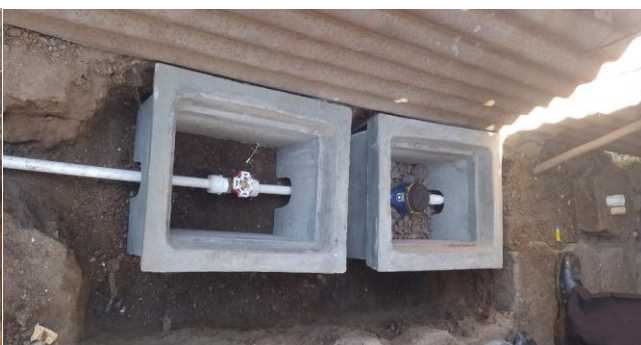
Instalación de tubería Hg, Poso Mecánico Caserío San Felipe, del municipio de San José Chacayá, Sololá.
