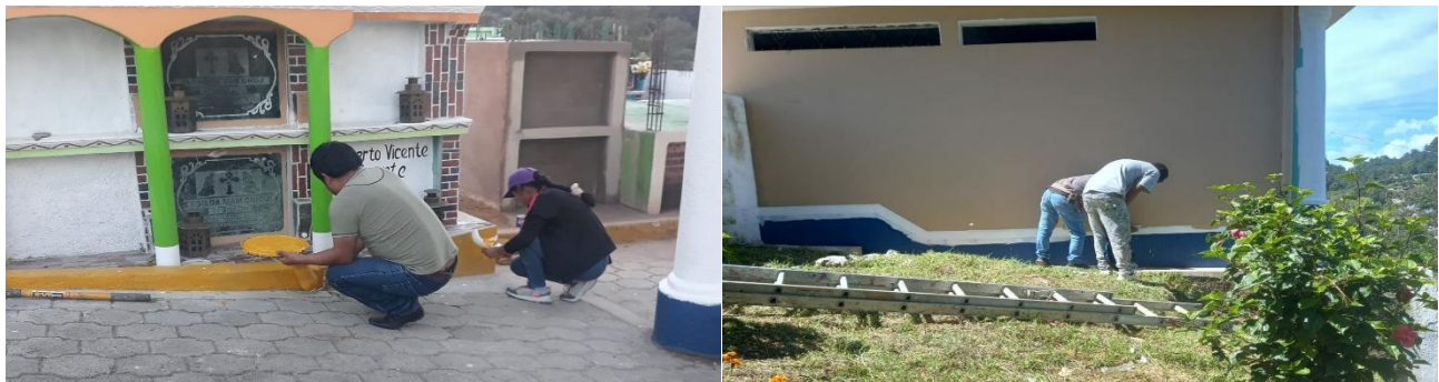
Limpieza, chapeo y mantenimiento del cementerio municipal.
