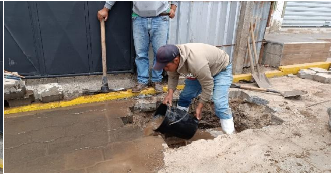
Reparación de tubería de línea de distribución del sistema de agua potable del Sector La Toma, Cabecera Municipal del municipio de San José Chacayá, Sololá.
