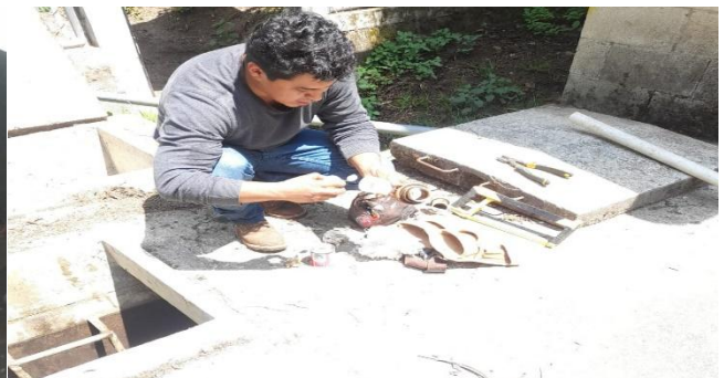
Mantenimiento y reparación de la bomba del sistema de agua potable del Caserío Chuimanzana, San José Chacayá, Sololá.
