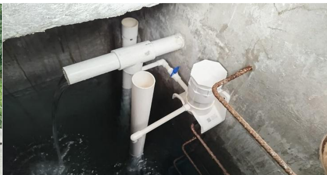
Instalación de Hipo-Clorador artesanal en sistema de agua potable Caserío Las Minas, San José Chacayá, Sololá.
