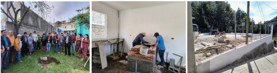
Mejoramiento Escuela Primaria Caserío Parromero, San José Chacayá, Sololá. Costo Total: Q 424,400.00
