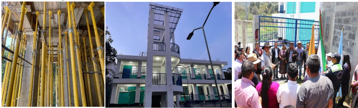
Construcción Instituto Diversificado Cabecera Municipal, San José Chacayá, Sololá. Costo Total: Q 899,940,000.00
