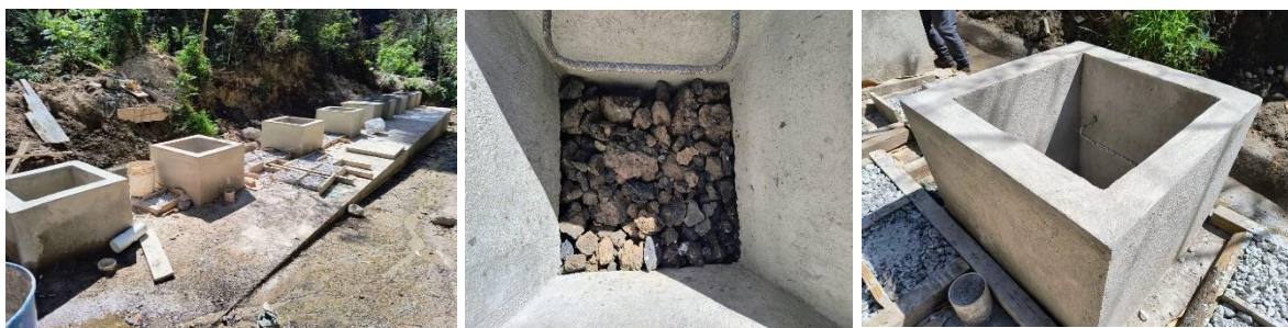
Mejoramiento Sistema de Agua Potable Caserío Las Minas, San José Chacayá, Sololá. Costo Total: Q 709,910.00
