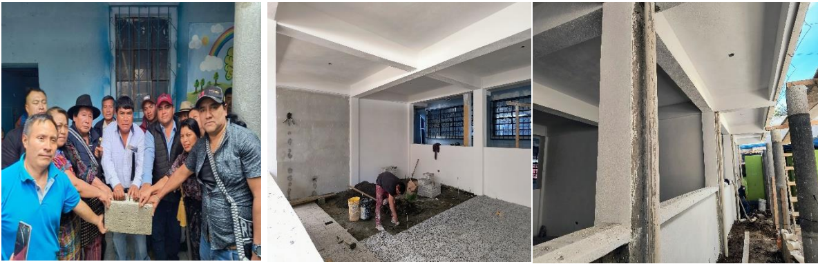
Mejoramiento Escuela Primaria Urbana, Cabecera Municipal, San José Chacayá, Sololá. Costo total: Q. 500,000.00
