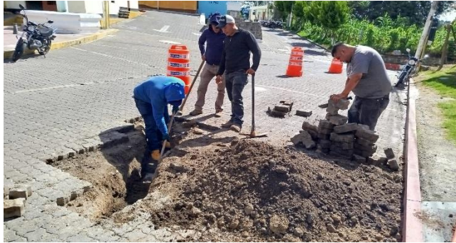
Reparación y mantenimiento, línea de distribución del sistema de agua potable Cabecera Municipal, San José Chacayá, Sololá.
