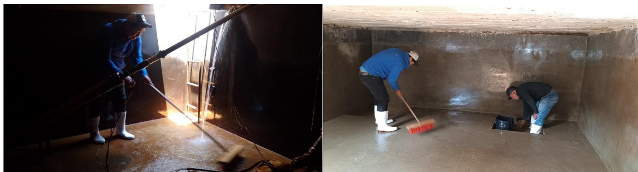
Lavado y desinfección de tanque de distribución, del sistema de agua potable del Caserío San Felipe, San José Chacayá, Sololá.
