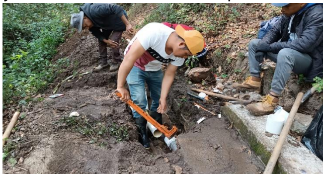
Reparación de tubería línea de conducción del sistema de agua potable del Sector La Toma y Caserío Las Minas del municipio de San José Chacayá, Sololá.
