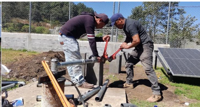
Instalación de tubería Hg, Poso Mecánico Caserío San Felipe, del municipio de San José Chacayá, Sololá.
