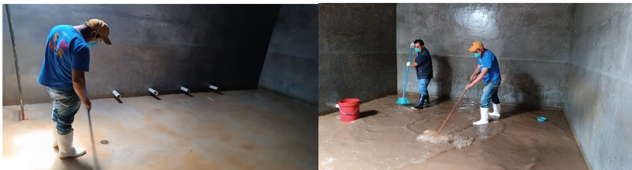
Lavado y desinfección del tanque de distribución del sistema de agua potable por gravedad y bombeo del Caserío Villa Linda, San José Chacayá, Sololá.
