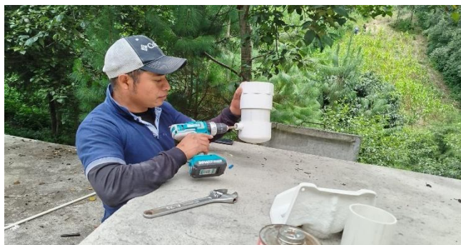
Instalación de Hipo-Clorador artesanal en sistema de agua potable Caserío Las Minas, San José Chacayá, Sololá.
