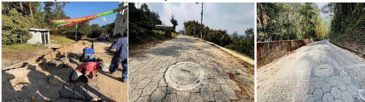
Ampliación Sistema de Tratamiento Aguas Residuales Caserío Chuimanzana, San José Chacayá, Sololá. Costo Total: Q 1,200,000.00
