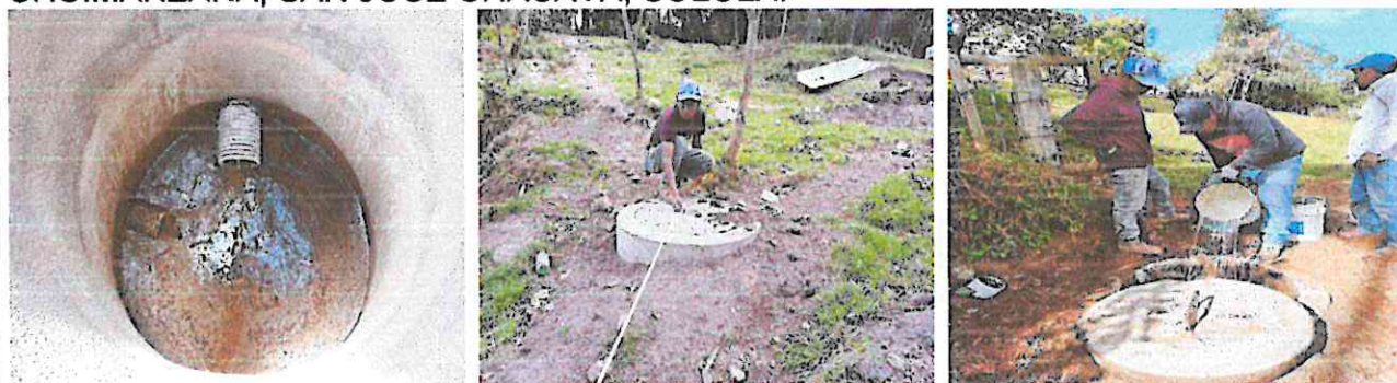
Actividad No. 3: Supervisión de avance físico del proyecto 80%: CONSTRUCCION SISTEMA DE ALCANTARILLADO SANITARIO SECTOR CHUTA, CASERIO CHUIMANZANA, SAN JOSE CHACAYA, SOLOLA.
