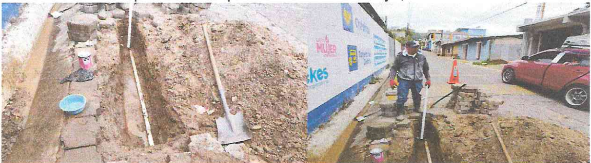
Actividad No. 8: Reparación de la red de distribución del Sistema de Agua Potable de la Cabecera Municipal del Municipio de San José Chacayá, Sololá.
