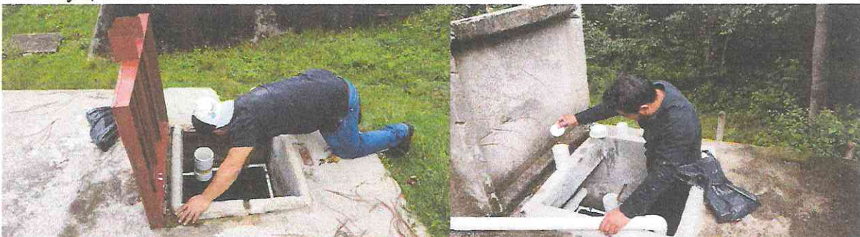
Actividad No. 6: Cloración de los Sistemas de Agua Potable del Municipio de San José Chacayá, Sololá.
