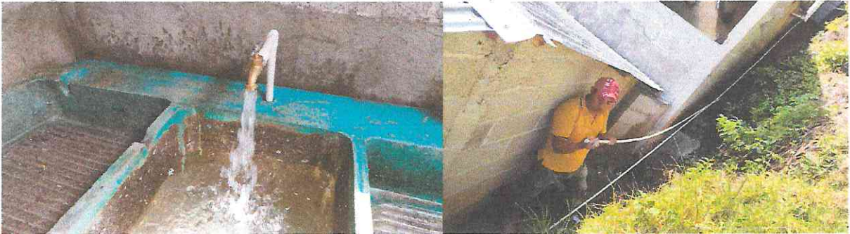
Actividad No. 9: Nuevas conexiones domiciliarias a la red de distribución del Sistema de Agua Potable del Caserío Chuacruz del Municipio de San José Chacayá, Sololá.
