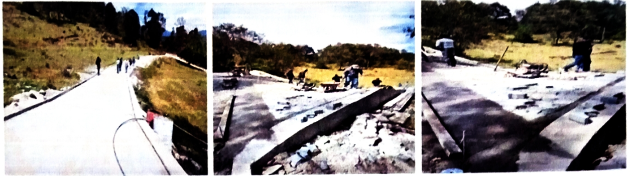
Actividad No. 8: Supervisión de avance del proyecto: AMPLIACION SISTEMA DE TRATAMIENTO AGUAS RESIDUALES, CASERIO CHUIMANZANA, SAN JOSE CHACAYA, SOLOLA.
