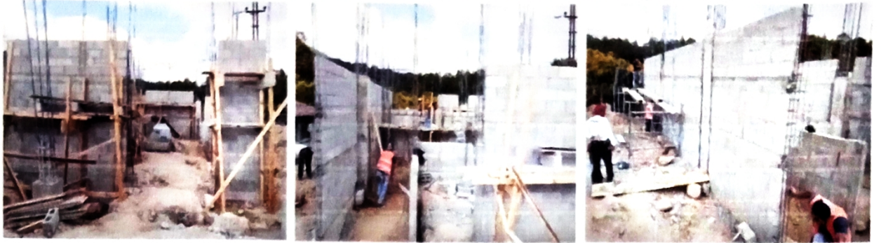
Actividad No. 5: Supervisión de avance del proyecto: MEJORAMIENTO SISTEMA DE AGUA POTABLE CASERIO LOS PLANES, SAN JOSE CHACAYA, SOLOLA.
