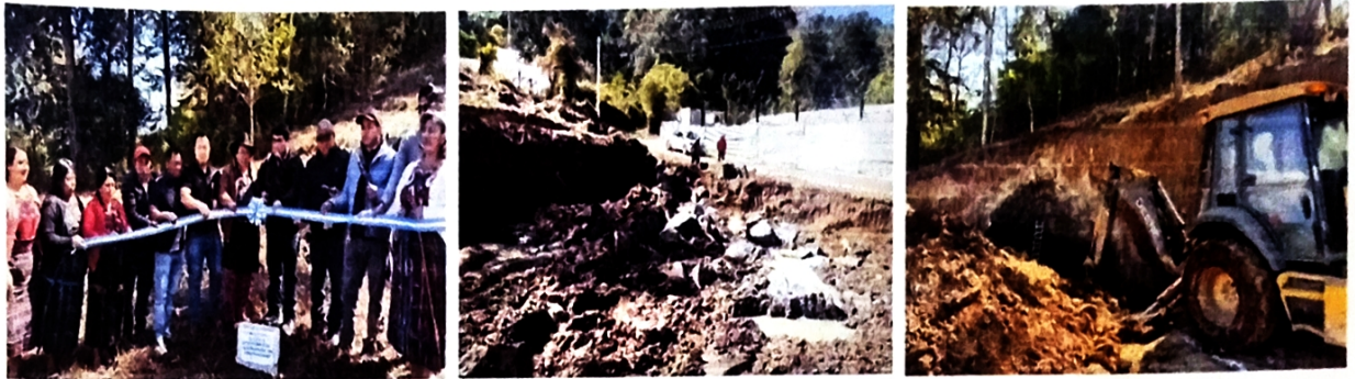
Actividad No. 5: Supervisión de avance físico del proyecto 35%: CONSTRUCCION CENTRO DE CAPACITACION INTERMUNICIPAL DE FORMACION EMPRESARIAL DE MUJERES PARA LA PROMOCION DE SU AUTONOMIA ECONOMICA, SAN JOSE CHACAYA, SOLOLA.
