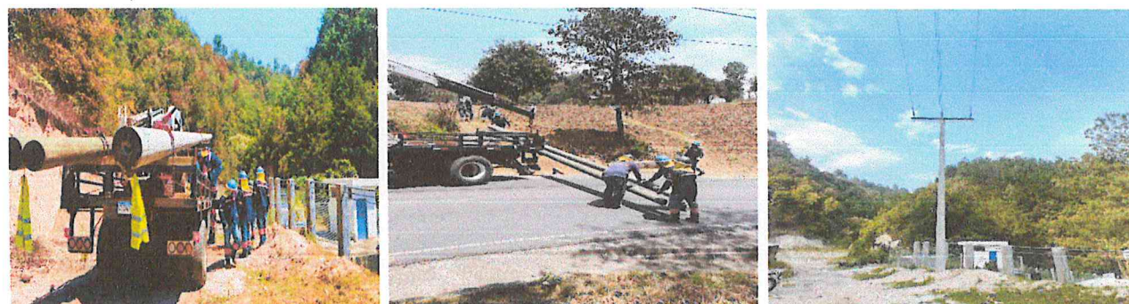
Actividad No. 10: Supervisión de avance físico del proyecto 50%: APOYO SERVICIOS DE ENERGIA ELECTRICA PARA SISTEMA DE AGUA POR BOMBEO, CASERIO LOS PLANES, SAN JOSE CHACAYA, SOLOLA.
