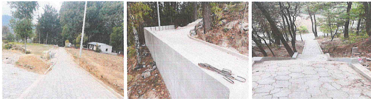
Actividad No. 9: Supervisión de avance físico del proyecto 55%: MEJORAMIENTO CAMINO RURAL SECTOR CEMENTERIO, COLONIA ROMEC, SAN JOSE CHACAYA, SOLOLA.
