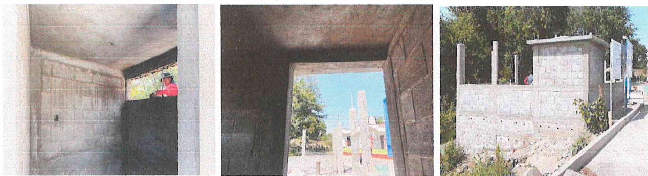
Actividad No. 8: Supervisión de avance físico del proyecto 45%: MEJORAMIENTO SISTEMA DE AGUA POTABLE CASERIO VILLA LINDA, SAN JOSE CHACAYA, SOLOLA.
