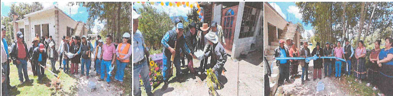
Actividad No. 11: Colocación de primera piedra del proyecto: MEJORAMIENTO CAMINO RURAL CASERIO CHUIMANZANA, SAN JOSE CHACAYA, SOLOLA.
