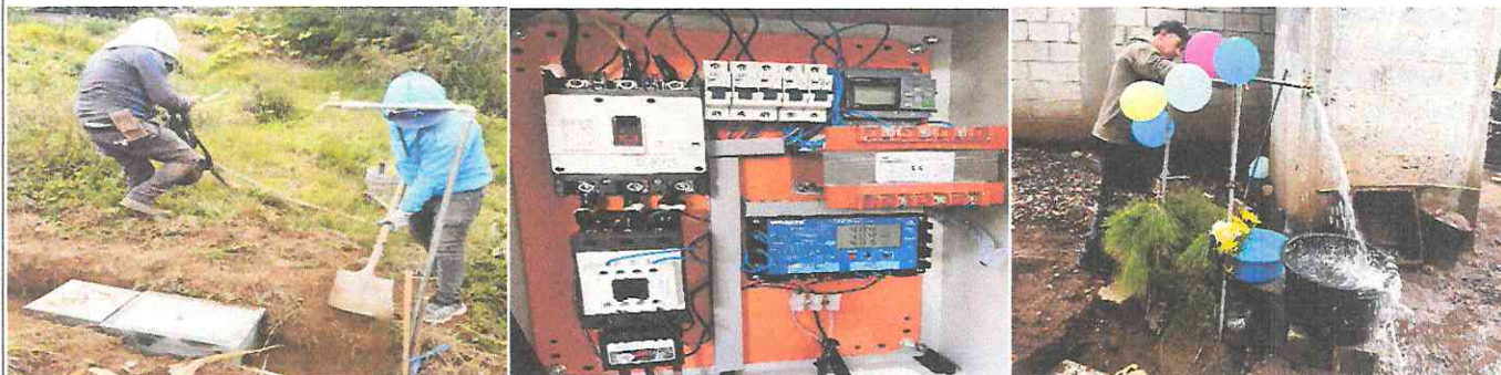
Actividad No. 3: Supervisión de avance físico del proyecto al 98%: MEJORAMIENTO SISTEMA DE AGUA POTABLE CASERIO LOS PLANES, SAN JOSE CHACAYA, SOLOLA.
